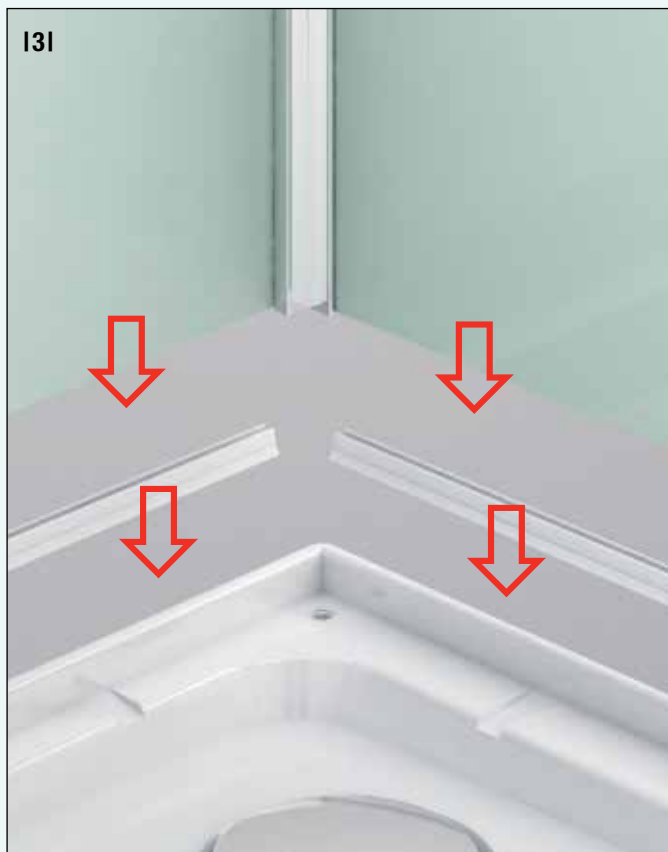
3. spojení zadních stěn a montáž spodního těsnění
